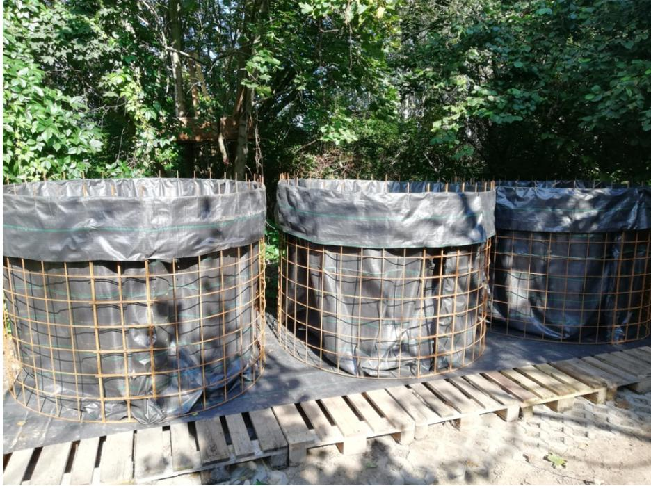
In unserer letzten Aufbauaktion am 14.9. haben wir nun die beiden ausstehenden Reaktoren zusammengebaut, verdrillt, verkleidet und die Anschlüsse für die Belüftung vorbereitet.
